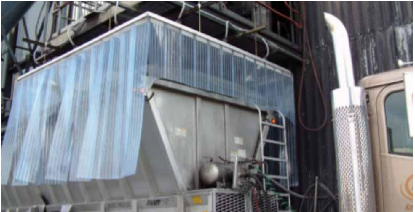
FIG. 3. A loadout hood
